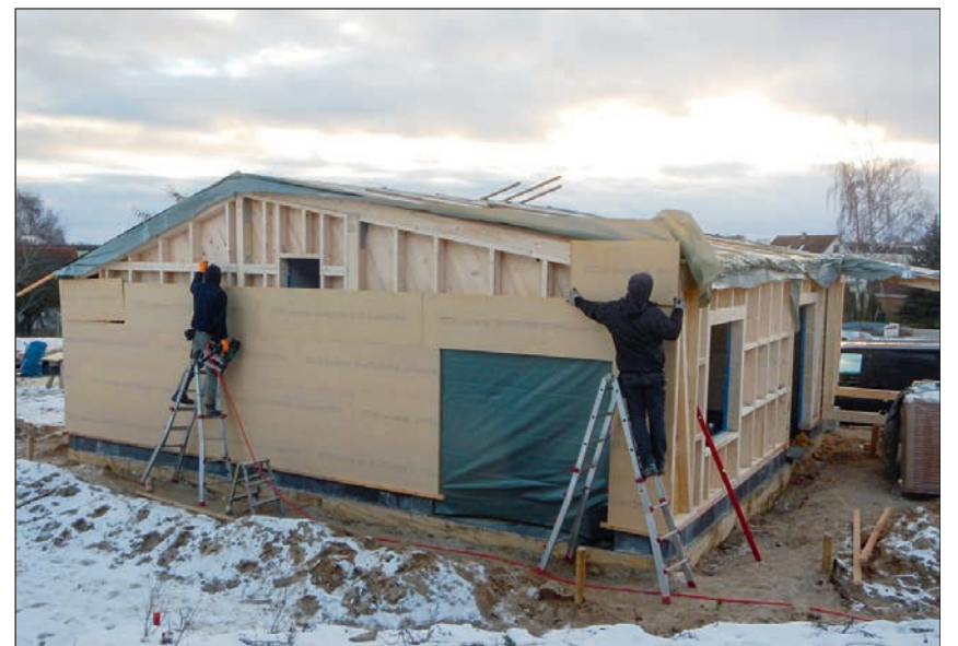
Anbringung der Holzfaserverplatten auf den KVH-Rahmen vor der Einblasdämmung. Foto: Das Meisterkollektiv/Daniel Poguntke
