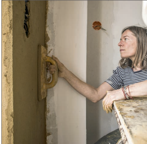
Der Auftrag des Feinlehmputzes im Innenraum erfolgte auf dem Nassverfahren hergestellten Holzfasersplatten, in denen die Installationen eingebracht wurden. Foto: Oliver Sachs
