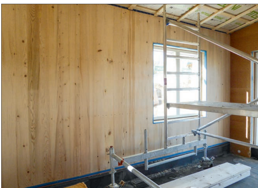
Die GFM-Verlegeplatte in rustikaler Sichtqualität dämmt, steift aus und ist zugleich Dampfbremse und luftdichte Ebene. Foto: Oliver Sachs
