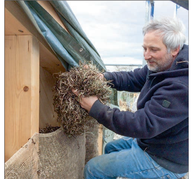
Als kleines, bauliches Experimentierfeld wurde das „Tiny House“ in der Siedlung mit lokalem Seegrass händisch hinter Jutematten gedämmt. Foto: Katrin Frische
