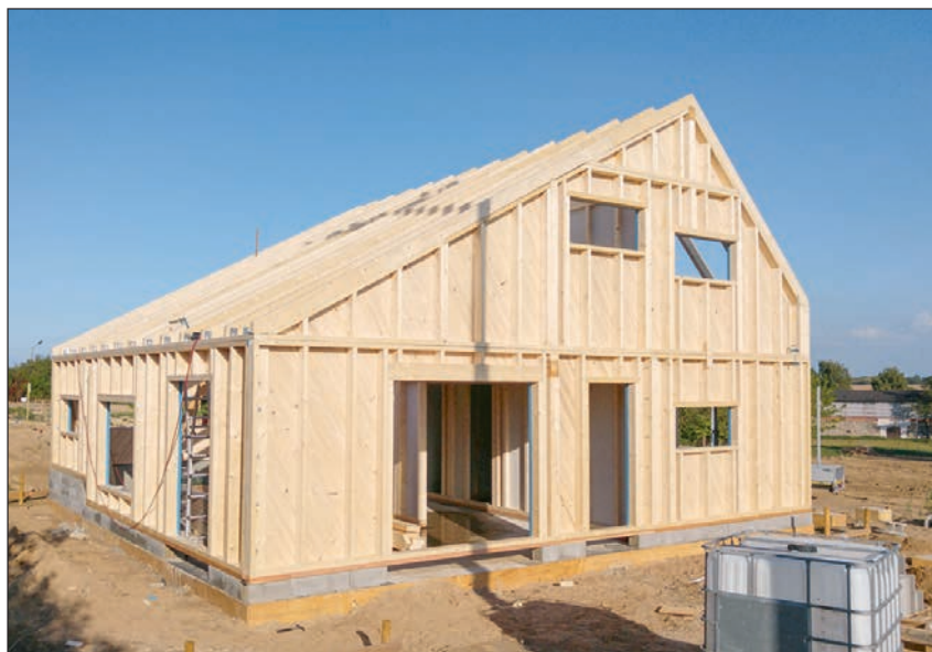
Reines Holz, keine Schadstoffe: die GFM-Diagonalplatte auf KVH-Rahmen. Foto: Rene Witt
